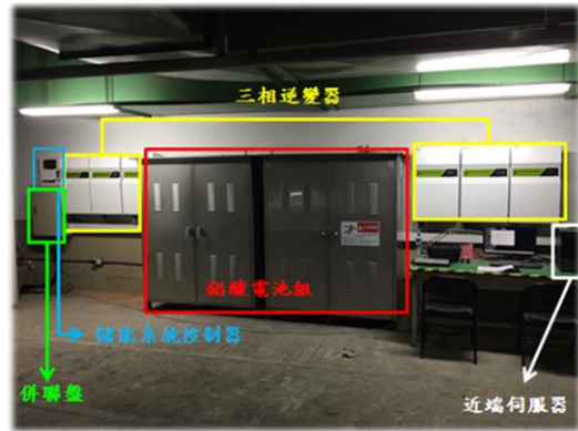
實場鉛酸電池儲能系統
